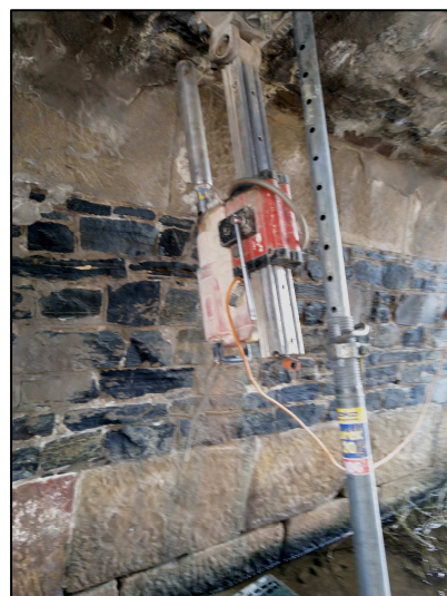
foto 8: Hloubení šikmého diagnostického vrtu DV5 do paty klenby jižní (krchlebské) opěry
