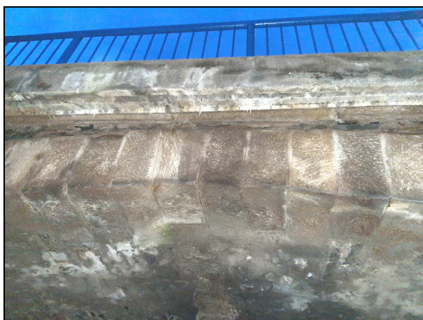
foto 17, 18: Neuspokojivý stav říms, v některých místech i částečná degradace povrchu
