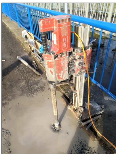
foto 9: Hloubení svislého diagnostického vrtu DV6 do vrcholu klenby
