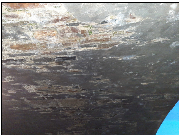
foto 13, 14: Stávající dílčí sanace líce klenby a části opěr stříkaným betonem (v současnosti jeho částečná degradace a opadávání), resp. zřejmé protékání vody nosnou konstrukcí (tj. nefunkční hydroizolační systém NK)
