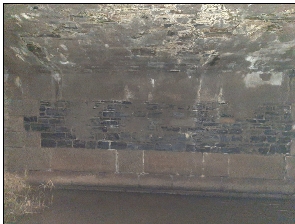
foto 13, 14: Stávající dílčí sanace líce klenby a části opěr stříkaným betonem (v současnosti jeho částečná degradace a opadávání), resp. zřejmé protékání vody nosnou konstrukcí (tj. nefunkční hydroizolační systém NK)
