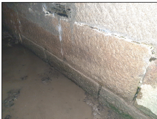
foto 15: Vydrolené spáry (především v úrovni dna říčky)
