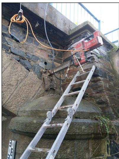
foto 11: Hloubení vodorovného diagnostického vrtu DV8 do poprsní zídky nad krajní opěrou
