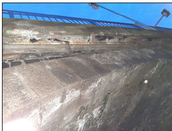
foto 17, 18: Neuspokojivý stav říms, v některých místech i částečná degradace povrchu
