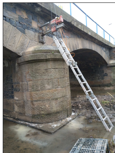
foto 10: Hloubení vodorovného diagnostického vrtu DV7 do poprsní zídky nad střední opěrou
