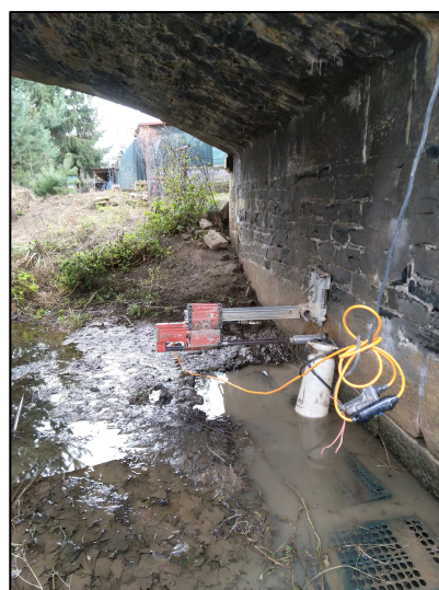
foto 4: Hloubení vodorovného diagnostického vrtu DV1 do severní (močovické) opěry
