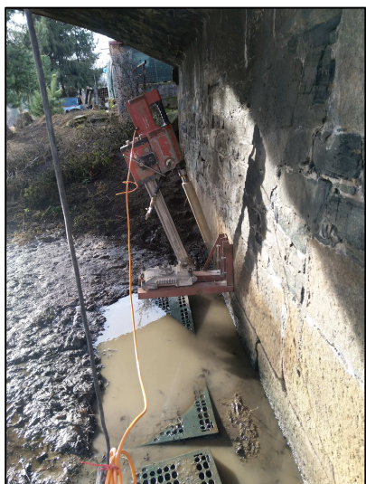
foto 7: Hloubení šikmého diagnostického vrtu DV4 do severní (močovické) opěry
