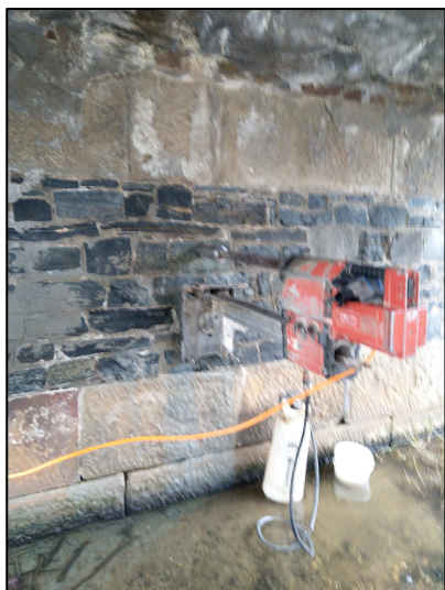
foto 5: Hloubení vodorovného diagnostického vrtu DV2 do jižní (krchlebské) opěry
